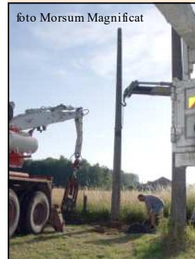
Palen voor proef worden geplaat
