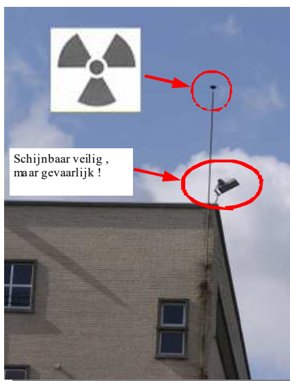
Campus St Jan - Het verlichtingsarmatuur staat op minder dan één meter en is niet eens verbonden met de afgaande leiding.
