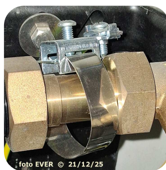
Hoofdequipotentiaal verbindingen tussen water- en gasleidingen ontbreken AREI Art. 4.2.3.2. “Aardingsinstallatie” en dat in meerdere woningen.
