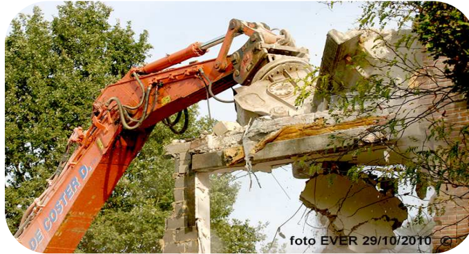
29 oktober 2010 - Afbraakwerken van 14 appartementen aan de Steenbergstraat 1 in Genk door aannemer De Coster Dominique NV, werken die schade aan andere gebouwen zouden veroorzaakt hebben.
