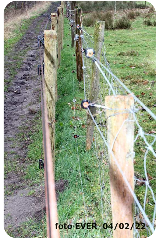
Foto links: gevaarlijke Situatie zoals wij het op 27 januari 2021 hebben gezien, aanraakbare blanke draden vlak naast een slijkerig wandelpad ! Foto rechts: Peer plaatste een reeks palen vóór de schrikdraad voorzien van lint. Dit is niet met kennis van zaken gerealiseerd.
