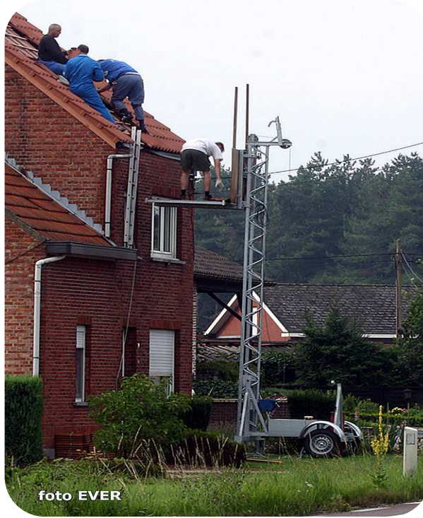
Voor zover wij weten is er op deze werf niets gebeurd, in Turkije waren het vier verdiepingen en daar liep het fataal af, bouwliften dienen niet om personen te hijsen, dat is zelfs verboden.
