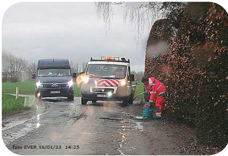
Twee uur na onze melding aan Aalter was de herstelploeg aan de Zuttershoek / Bellemstraat ter plaatse.
