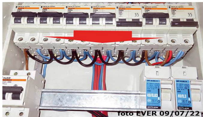
Draadbruggen van 4 mm² mogen maximum met 34 Ampère beveiligd worden.
