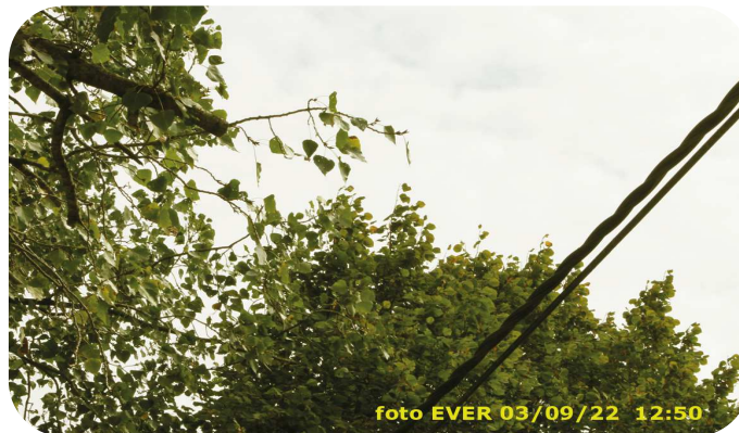
Foto boven op 27 augustus 22: Grote tak ligt op het laagspanningsnet. Foto onder 03 september: tak werd, na interventie van Morsum Magnificat bij Fluvius, binnen enkele dagen van de BAXB verwijderd. Technici bij Fluvius weten maar al te goed hoe gevaarlijk zo'n situatie is.
