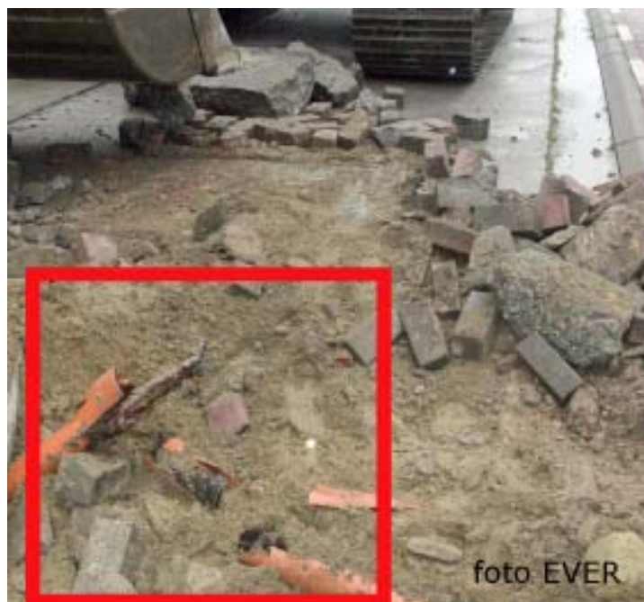
De hoogspanningskabel -15kV- kruiste de weg op ongeveer 37cm diep ! Een oranje plastic buis was de enige bescherming, er was geen andere bescherming noch éni- g waarschuwingsslint.
